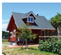
员工第一疗养所2(尾道市向岛)
