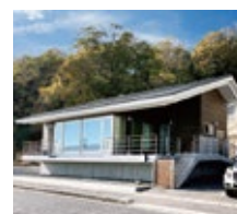
员工第一疗养所3(尾道市向岛)
